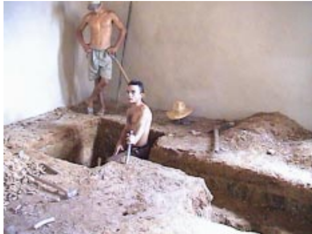
Preparação para instalação de mini-usina Fonte: COEP
