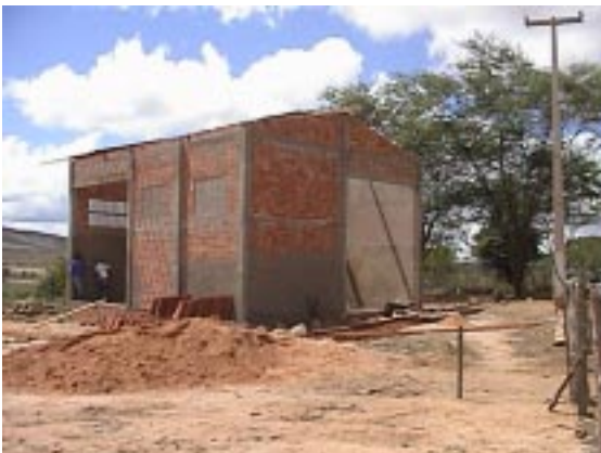
Galpão de Quixabeira em construção Fonte: COEP
