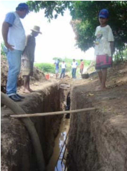
Construção de barragem subterrânea Fonte: COEP
