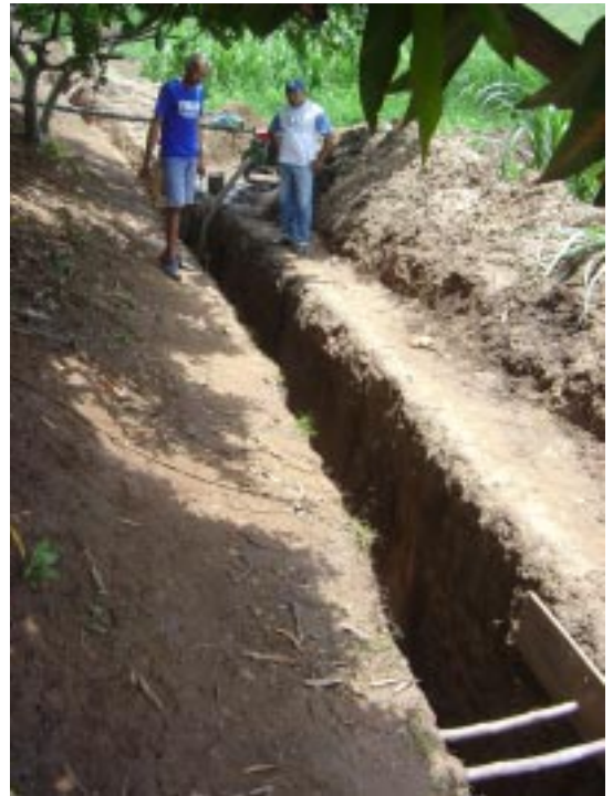
Construção de barragem subterrânea Fonte: COEP
