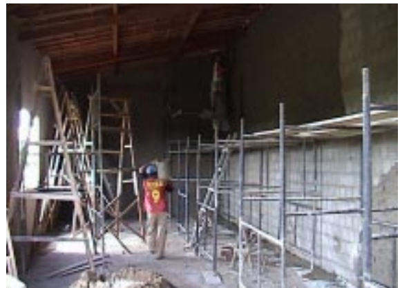
Galpão de Lagoa de Dentro em construção Fonte: COEP
